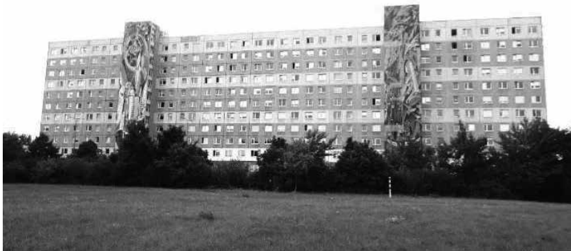
A la derecha El dominio de la naturaleza por el hombre , y a la izquierda Unidad de la clase trabajadora y fundación de la República Democrática Alemana en la antigua residencia de estudiantes, actualmente Departamento de Asuntos Residenciales. Fotografía tomada por el autor.
